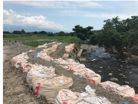
▲市道 真野6号線 小川内川
