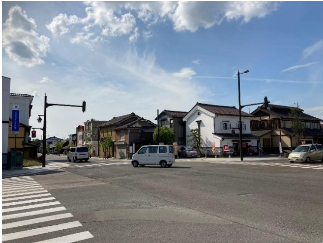
▲七日町の主要交差点の電線地中化すっきりとした印象になっている
