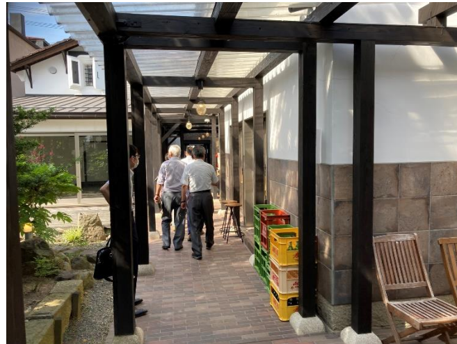
▲蔵を再生し、ポリカーボネート屋根を設置した共有スペース
