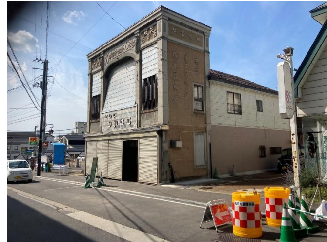
▲ファサード（建物の正面）が強調された看板建築も見られた
