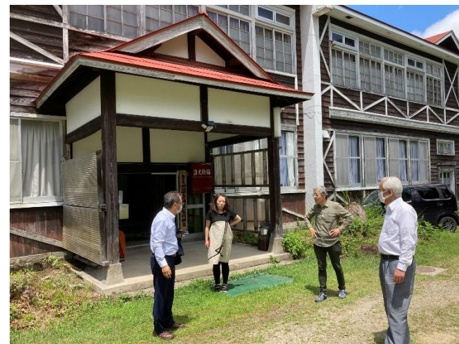
▲昭和13年建築の木造2階建校舎は有志の思いで保存活用している
