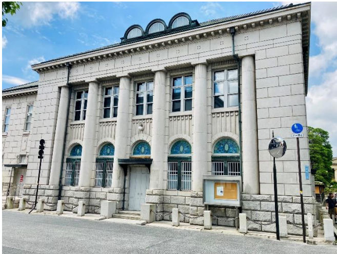
▲大原美術館新児島館（仮称）外観 大正11年 旧中国銀行倉敷本町支店
