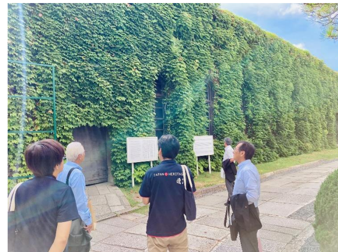
▲蔦を絡めて環境効果を出す努力を当時から行っていたとのこと
