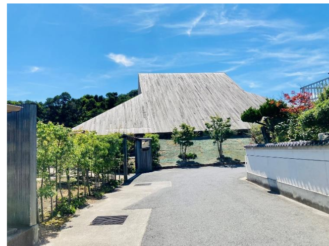
▲環境へ配慮した、直島町役場隣の直島ホール（設計：三分一博氏）
