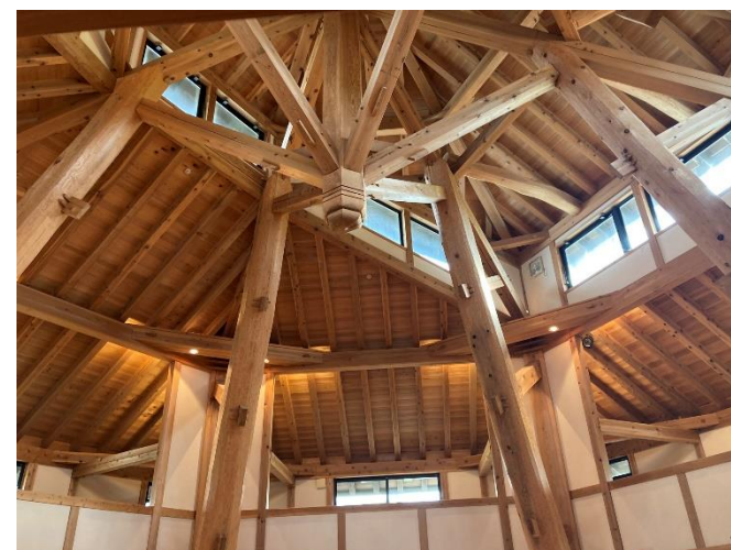
▲新潟県森林組合連合会越後森林館 和傘のような天井の大空間を実現
