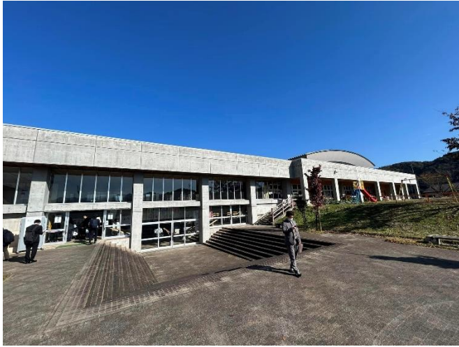
▲校舎の外観、駐車場からのアクセスを容易にしている
